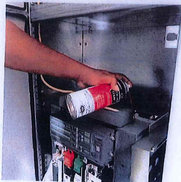
ภาพชุดที่ 8 ขณะดำเนินการทำความสะอาดและฉีดน้ำยาทำความสะอาดหน้าสัมผัส และ รางดับอาร์คของ ACB เพื่อยืดอายุการใช้งาน
